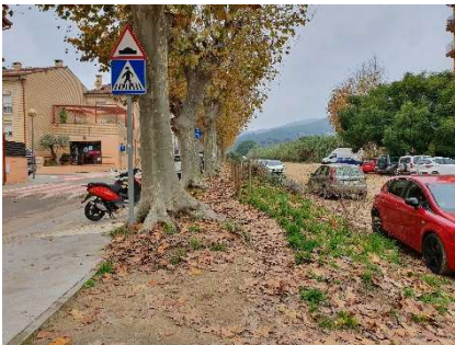
Arbres amb meitat del sistema radicular pavimentat. Talús amb plantes per evitar al màxim l'erosió. Carretera de Lourdes
