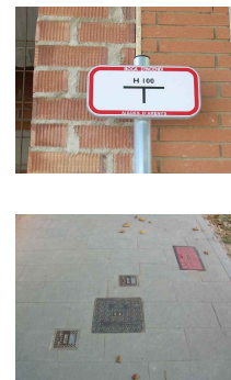
Extrem sud-oest de la Riera. Hidrant i pericons vàlvules aigua.
