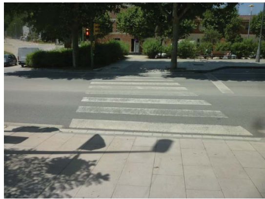
Imatge 4. Pas de vianants ramal nord.
