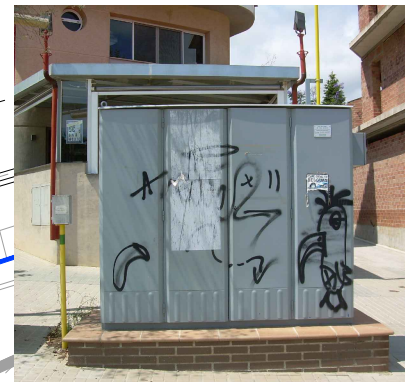
Estació de regulació existent EMM-0029-08007 Gas Natural
