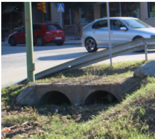
Pas d'aigües pluvials sota carretera obsolets Sortida de les aigües provinents del barri de Sant Carles
