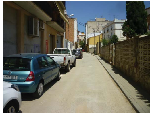
Imatge 19. Vores de 0,75 m, calçada de 4,4 m.
