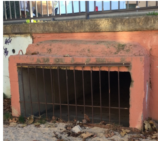
Pas d'aigües pluvials sota carretera obsolets Sortida de les aigües provinents del barri de Sant Carles
