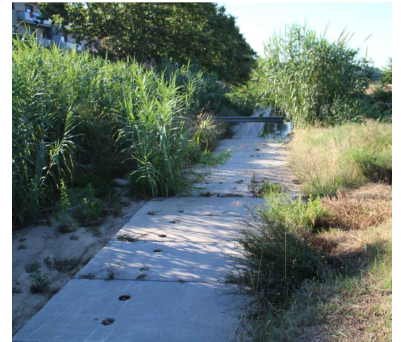
Tram final dels calaixos de pluvials soterrats.
