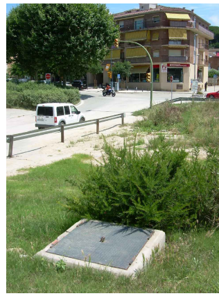
Pericó instal·lació de reg zona sud de la Riera
