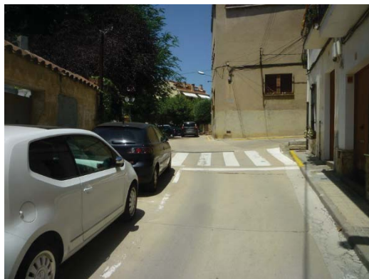
Imatge 25. Visibilitat deficient en pas de vianants.
