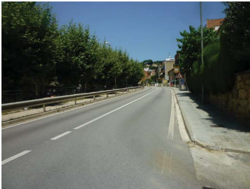
Imatge 31. Vista a la dreta (cap a centre Arenys de Munt)..
