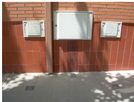
Escameses aigua i gas, davant edifici n° 23-25.
