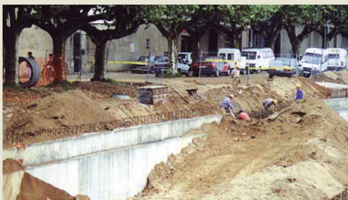
La canalització de la riera d'Arenys va començar el 1996
