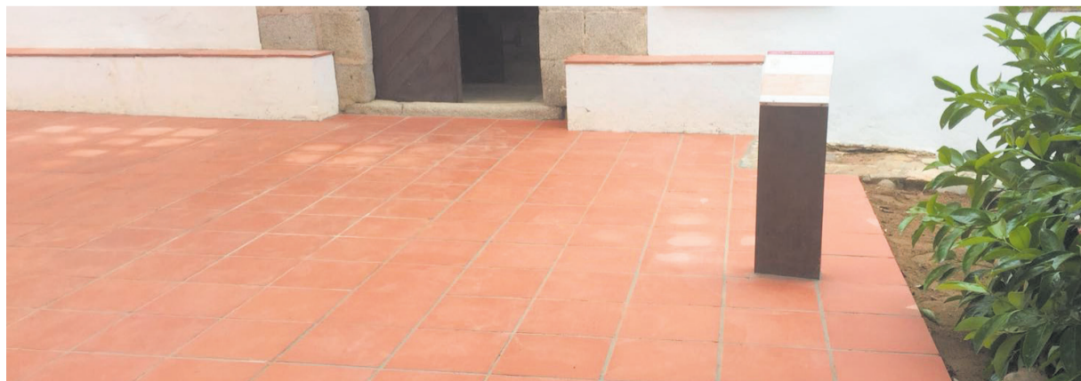
Pavimentació a l'entrada de la masia Can Borrell
