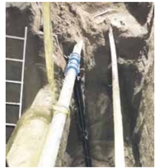
Reparació de la fuga
