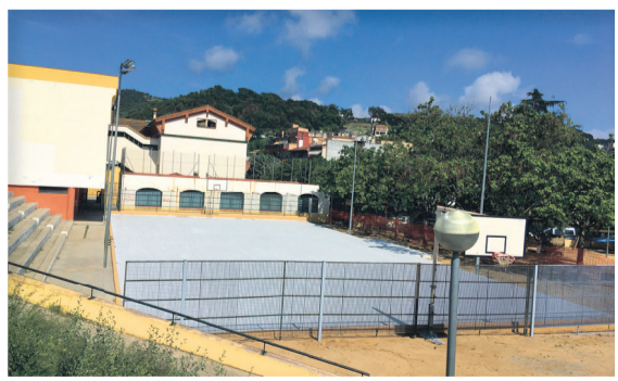
Enllestides les obres de la pista de Sant Martí
