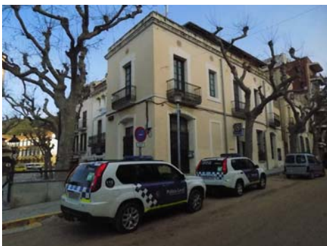
Edifici de Can Matalí, seu de la Policia Local
