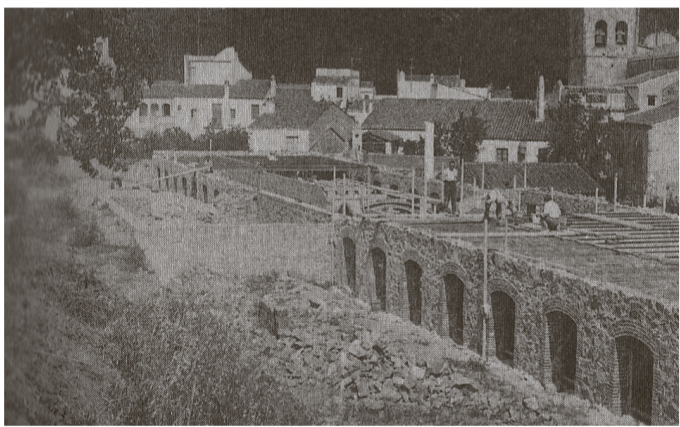
Treballs de construcció de l'escola Sant Martí l'any 1934. Fotografia Neus Catà
