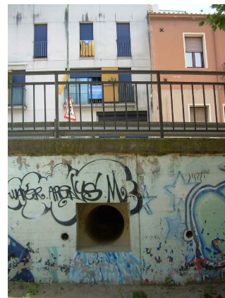
Sota la C-61, desguàs a la Riera.
