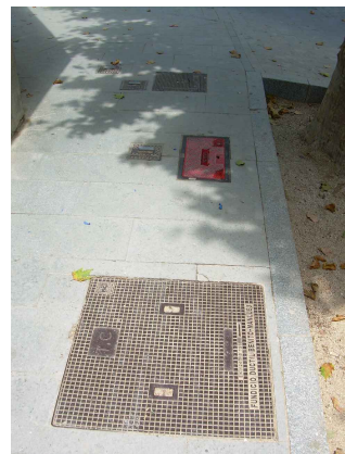
Cantonada sud Riera amb c/. de la Rasa. Vàlvules xarxa aigües i hidrant.
