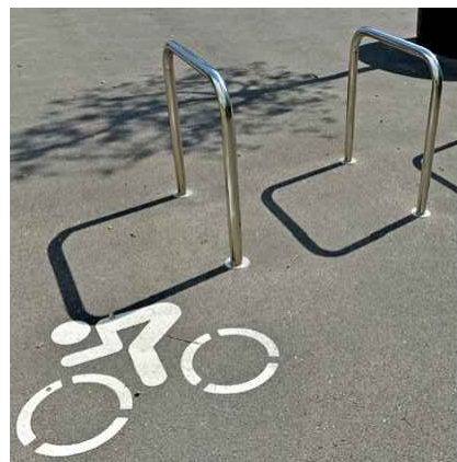
Aparcament bicicletes en "U" invertida d'acer.
