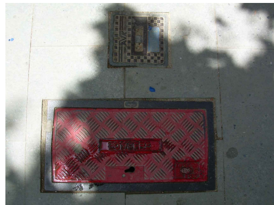
Cantonada sud Riera amb c/. de la Rasa. Vàlvules xarxa aigües i hidrant.
