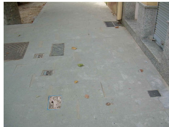
Cantonada sud Riera amb c/. Pompeu Fabra. Vàlvules xarxa aigües i boca de reg.
