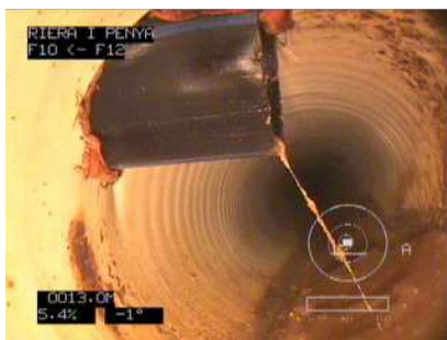
Connexió lateral entre pous 10-12.
