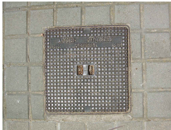
Detall tapa registre pericons aigües potables.
