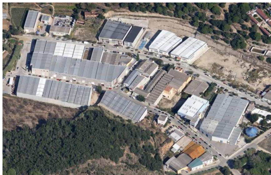
Vista parcial del sector industrial del rial d'en Puig (Font: Google Maps)
