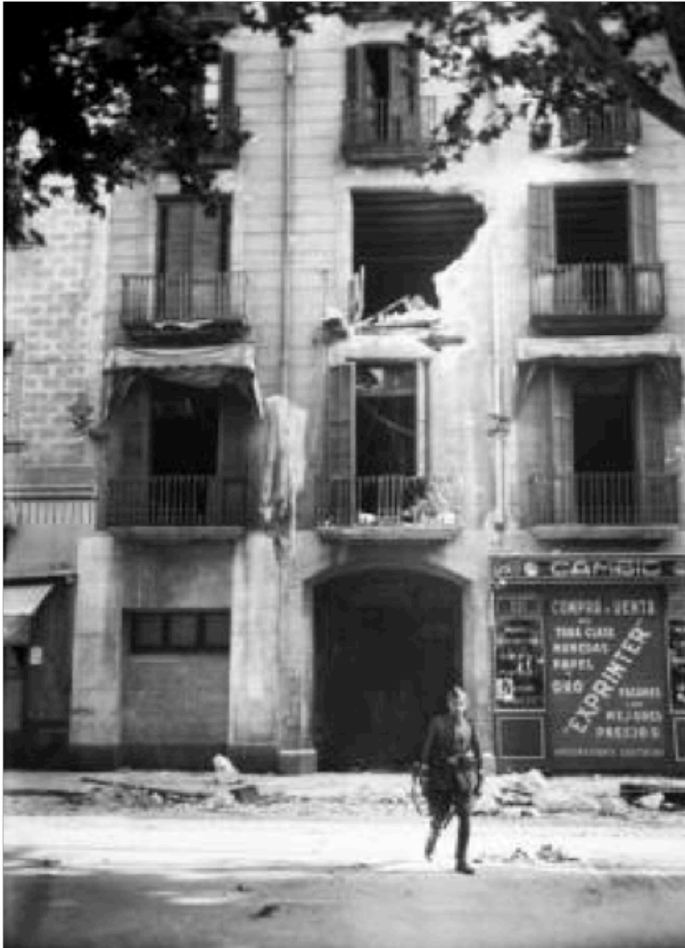
Estat en què quedà el local del CADCI
