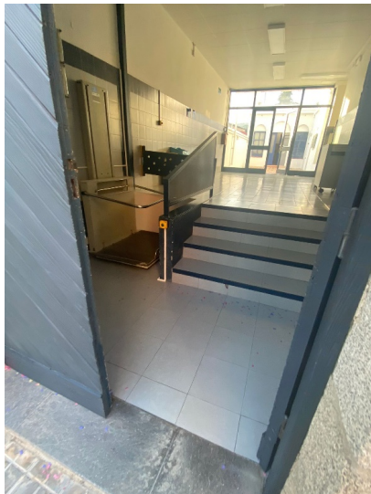
Elevador edifici Biblioteca
